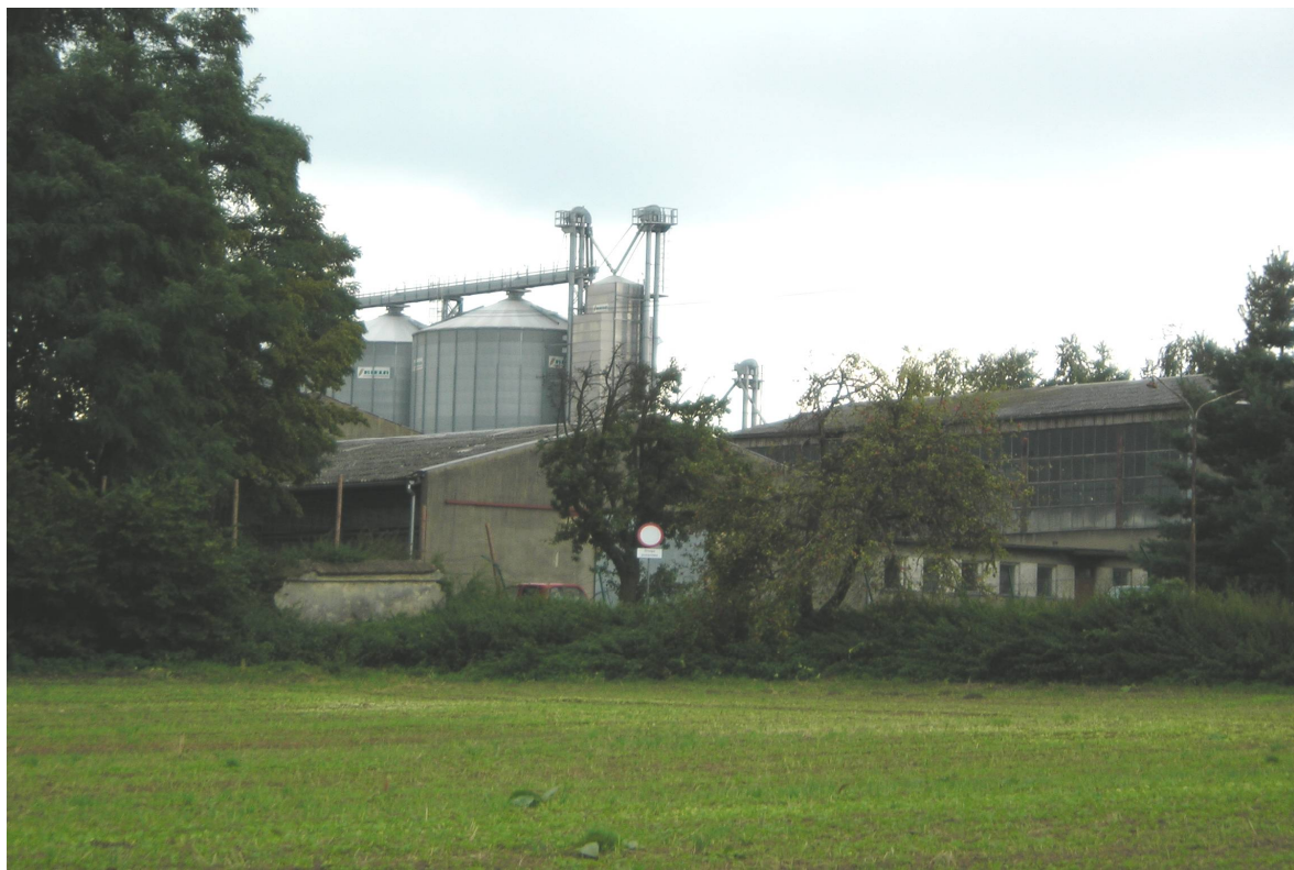
Fot. 4 Dach azbestowy na obiektach firmy (wieś Tomice).
