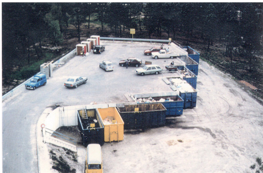
Rys. 9 Rampa wyładowcza dla wielu pojazdów
