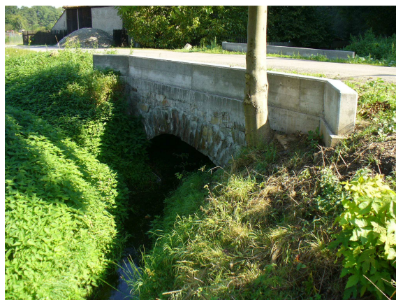
Fot. 40. Przepust w Muszkowicach
