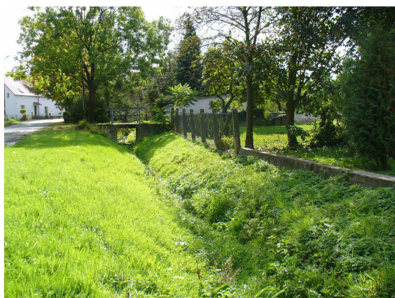
Fot. 43. Rów w pasie drogi w Ciepłowodach
