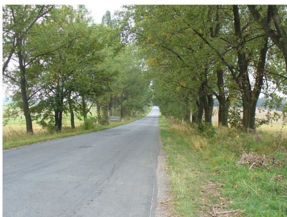
Fot. 63. Rony w pasie drogi do konserwacji w Piotrowicach Polskich
