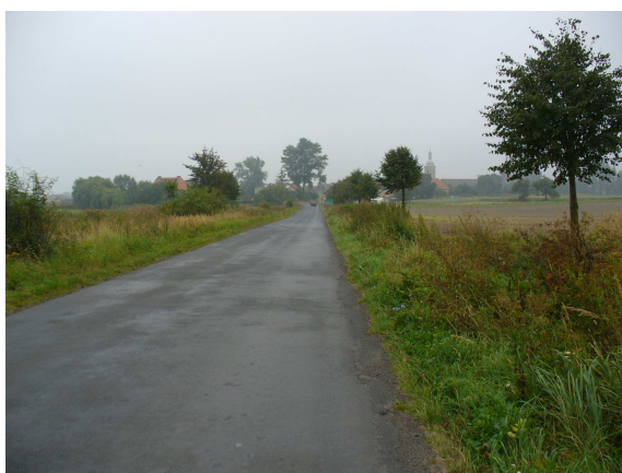
Fot. 59. Rowy w pasie drogi do konserwacji w Starym Henrykowie
