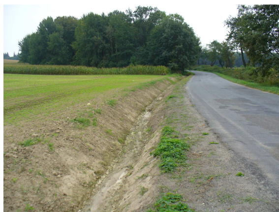
Fot. 44. Odbudowany rów w Kobylej Głowie
