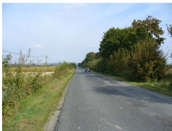
Fot. 64. Rony w pasie drogi do konserwacji w Ciepłowodach
