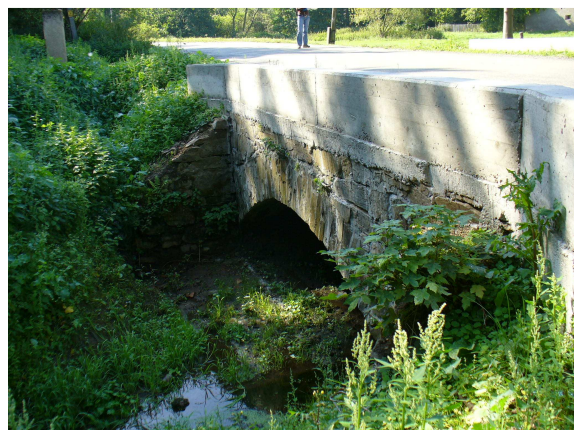
Fot. 41. Przepust w Muszkowicach
