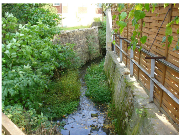
Fot. 57. Umocnienia betonowe na cieku Mała Śleza w Ciepłowodach
