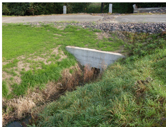
Fot. 42. Przepust w Tomicach
