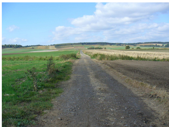
Fot. 48. Droga szutrowa transportu rolnego w Ciepłowodach
