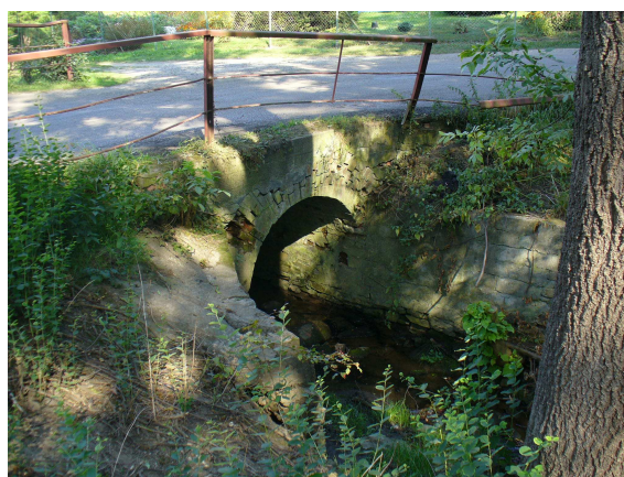
Fot. 60. Przepust do odbudowy w Cienkowicach
