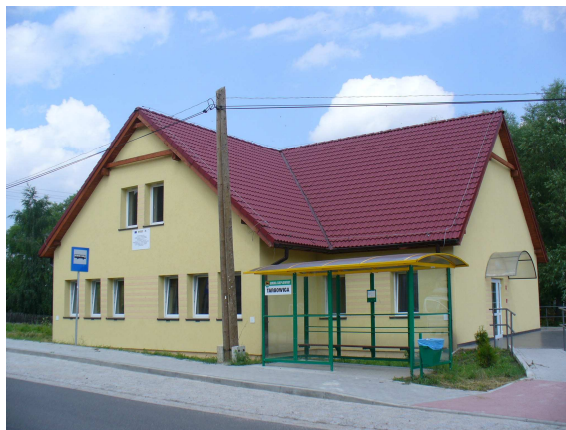
Fot. 56. Świetlica wiejska w Targowicy
